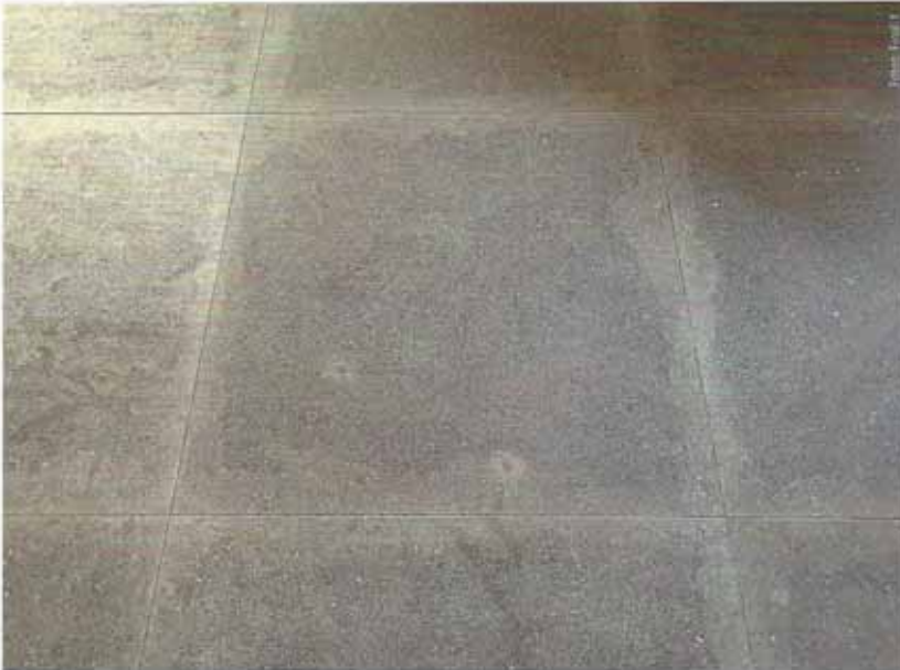
Deutlich erkennbar ist die unregelmäßige Fugenrandverfärbung auf dem Sandsteinboden.
