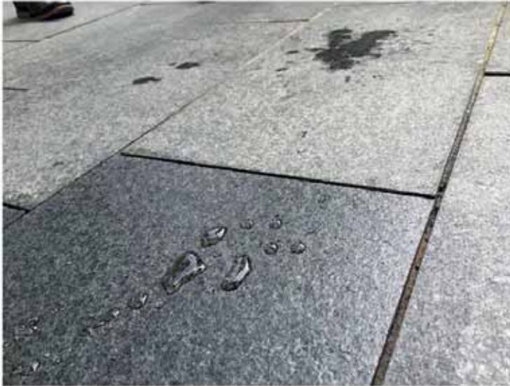
Imprägnierung mit Abperleffekt (vorn).
