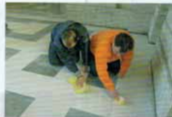
MARMORBODEN. Rutschhemmung und Schutz in den Arkaden
