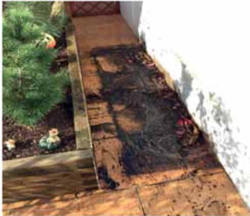
Platten aus Quarzit im Außenbereich vor und nach der Reinigung.
