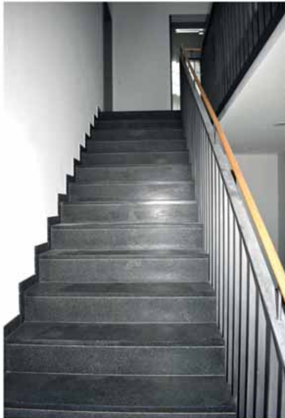
Wieder vorzeigbar; Durch die professionelle Behandlung mit sauren und neutralen Reinigern konnten selbst hartnäckige Verschmutzungen und Rückstände entfernt werden.
