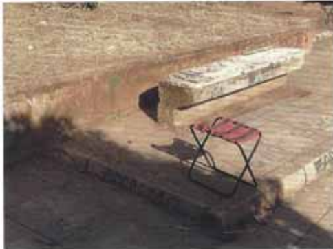
Schattierungen und Rückstände bleicht das Reinigungsteam mit basischem Finalit-Fleckenkiller aus
