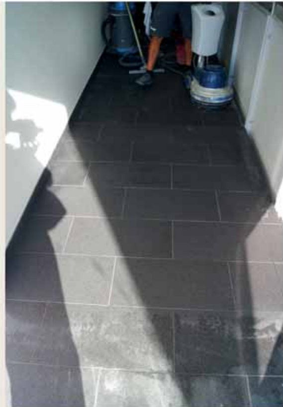
Deutlicher Unterschied: Die Fliesen im hinteren Bereich wurden bereits behandelt.
