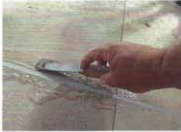
Der Fett- und Wachs-Entferner wird mit einem Spachtel messerrückendick auf die betroffenen Stellen aufgetragen.
