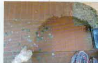
KAUGUMMI. Entfernung auf Klinkerboden
